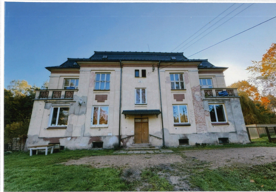
Fot. 11. Budynek mieszkalny administracji [3], widok na elewację zachodnią
