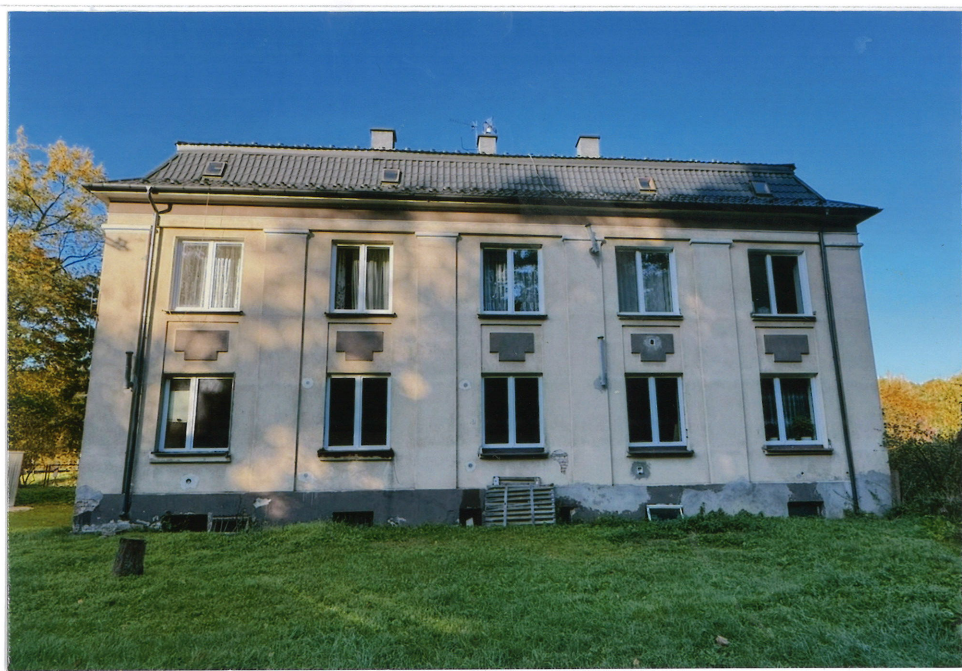
Fot. 12. Budynek mieszkalny administracji [3], widok na elewację wschodnią
