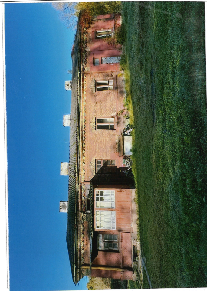
Fot. 9. Budynek mieszkalny zawiadowcy [2], widok na elewację wsch.
