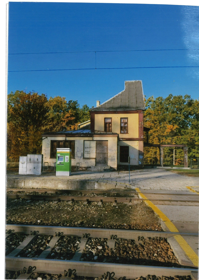
Fot. 2. Budynek główny [1], widok na elewację wschodnią
