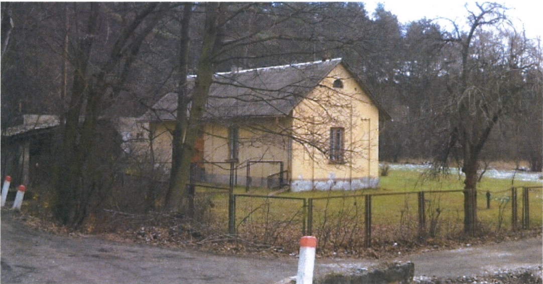
Fot. 16. Budynek zawiadowcy przejazdu stacji. →
