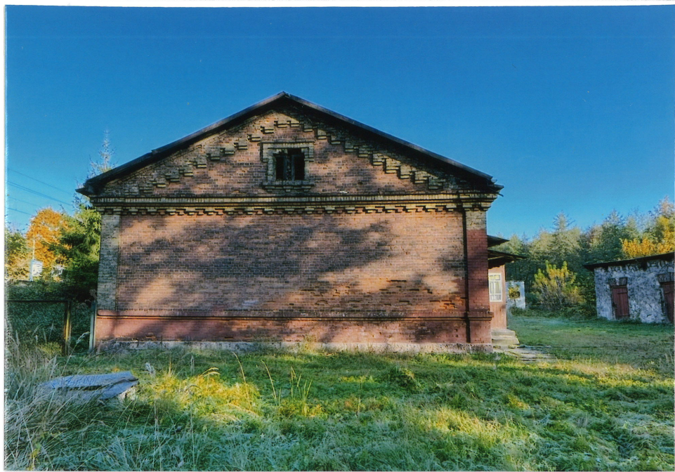
Fot. 10. Budynek mieszkalny zawiadowcy [2], widok na elewację południową
